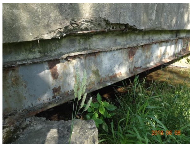
Fot. 8 (źródło: materiały kontrolne GUNB). Skorodowany dźwigar stalowy i odsłonięte zbrojenie belki płyty mostu.
