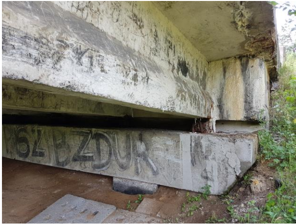
Fot. 3 i 4 (źródło: materiały kontrolne GUNB). Przyczółek mostu – ubytki umocnień i gruntu skarpy przyczółka, lokalna korozja belek przęsła, ubytki korozja i zacieki na powierzchni bocznej oczepu i skrzydeł przyczółka, lokalne ubytki betonu gzymsu skrzydła, intensywna korozja łożysk przyczółka, przebarwienia od przecieków oczepu i skrzydeł przyczółka, ubytki powierzchniowe, ubytki betonu oczepu i skrzydeł podpory, korozja chlorkowa, korozja i uszkodzenia powierzchniowe ławy łożyskowej przyczółka.
