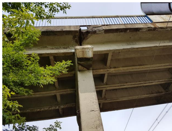
Fot. 1 i 2 (źródło: materiały kontrolne GUNB). Przęsło środkowe mostu – korozja belek skrajnych, lokalnie odkryte w stanie korozji powierzchniowej zbrojenia belek, lokalne ubytki krawędzi belek, przecieki i przebarwienia solne, przebarwienia od spalin pociągów na spodzie belek i poprzecznic, korozja, nacieki solne, lokalne i powierzchniowe ubytki gzymsów, korozja i ubytki powierzchniowe betonu.
