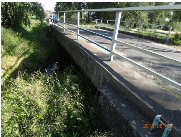
Fot. 7 (źródło: materiały kontrolne GUNB). Spękania belki płyty mostu.
