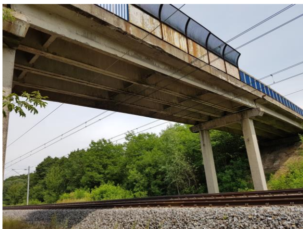
Fot. 1 i 2 (źródło: materiały kontrolne GUNB). Przęsło środkowe mostu – korozja belek skrajnych, lokalnie odkryte w stanie korozji powierzchniowej zbrojenia belek, lokalne ubytki krawędzi belek, przecieki i przebarwienia solne, przebarwienia od spalin pociągów na spodzie belek i poprzecznic, korozja, nacieki solne, lokalne i powierzchniowe ubytki gzymsów, korozja i ubytki powierzchniowe betonu.
