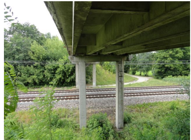
Fot. 5 i 6 (źródło: materiały kontrolne GUNB). Filar mostu - odsłonięte strzemiona oczepu w stanie korozji, korozja belek przęsła, przebarwienia od przecieków i korozji na oczepie i słupach, odsłonięte zbrojenie słupów i oczepu filara, ubytki powierzchniowe oraz odsłonięte, korodujące zbrojenie słupów filara.
