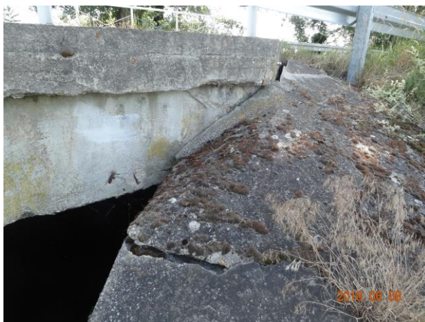
Fot. 9 (źródło: materiały kontrolne GUNB). Spękania przyczółku
