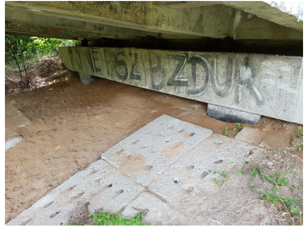
Fot. 3 i 4 (źródło: materiały kontrolne GUNB). Przyczółek mostu – ubytki umocnień i gruntu skarpy przyczółka, lokalna korozja belek przęsła, ubytki korozja i zacieki na powierzchni bocznej oczepu i skrzydeł przyczółka, lokalne ubytki betonu gzymsu skrzydła, intensywna korozja łożysk przyczółka, przebarwienia od przecieków oczepu i skrzydeł przyczółka, ubytki powierzchniowe, ubytki betonu oczepu i skrzydeł podpory, korozja chlorkowa, korozja i uszkodzenia powierzchniowe ławy łożyskowej przyczółka.
