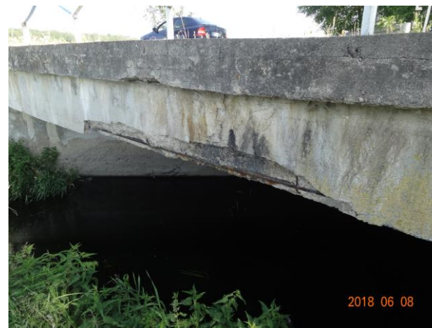
Fot. 8 (źródło: materiały kontrolne GUNB). Skorodowany dźwigar stalowy i odsłonięte zbrojenie belki płyty mostu.
